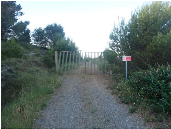
Illustration 25 : Portail d'accès au site de l'ARTUS, dégradé
