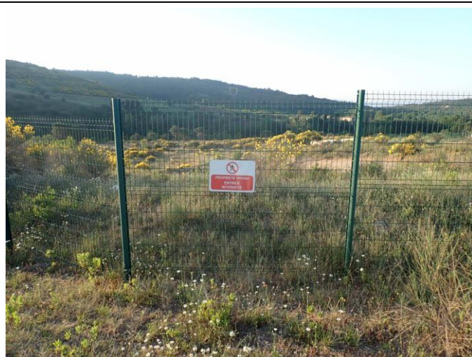
Illustration 2 : Panneau de restriction d'accès le long de la clôture de l'alvéole Big-bag
