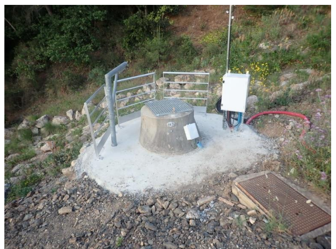
Illustration 18 : Point V, travaux d'aménagement finalisés
