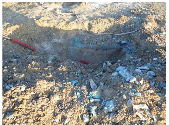
Illustration 16 : Tranchée ouverte sur site
