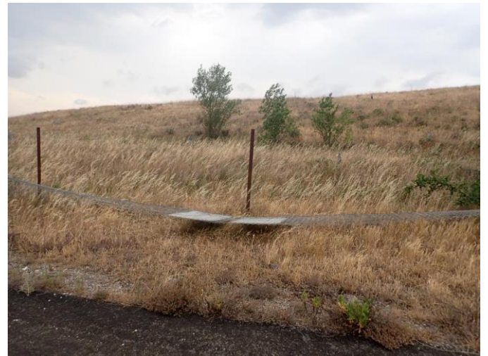
Illustration 38 : Clôture effondrée au droit de panneaux mis en place à proximité de l'ancien portail d'accès
