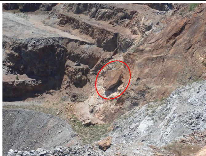
Illustration 48 : Bloc éboulé sur une paroi de la MCO
