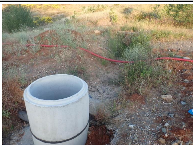
Illustration 24 : Avaloir bétonné de la source Arsine
