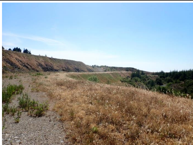
Illustration 45 : Banquettes stables en partie Nord du site
