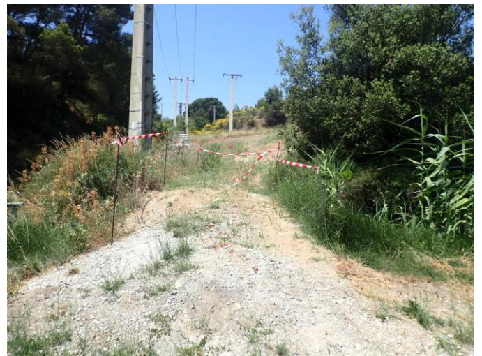
Illustration 14 : Rampe d'accès au point V depuis la RD101
